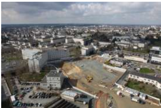
Photo N°5 : chantier le 10 mars 2013
