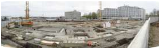
Photo N° 3 : chantier le 16 avril 2013
