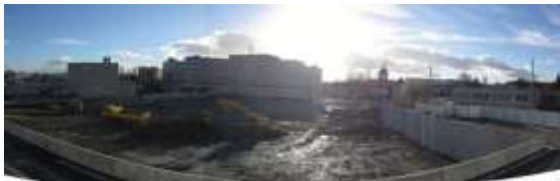
Photo N° 1 : chantier le 10 janvier 2013
