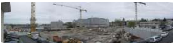
Photo N° 4 : chantier le 16 avril 2013
