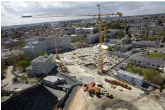
Photo N°6 : chantier en mai 2013
