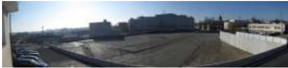
Photo N° 2 : chantier le 18 février 2013
